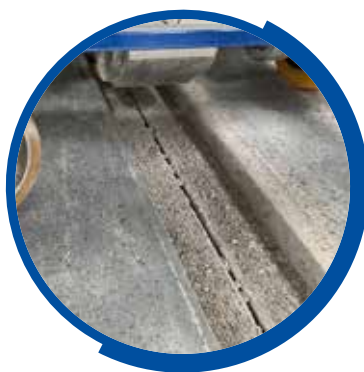
CREAZIONE SCASSO PER GIUNTO TRAVETTO
