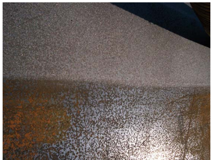
5 - Un particolare della preparazione del fondo: l'aspetto minimo richiesto, in alto di figura, è di SA 2,5.
