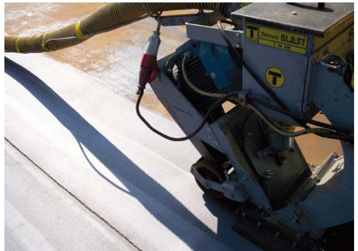
3 e 4 - Una fase operativa della pallinatrice: con l'asportazione del vecchio rivestimento le lamiere vengono messe a nudo in modo da consentire l'identificazione immediata di eventuali danni o corrosioni e l'intervento tempestivo di riparazione.
