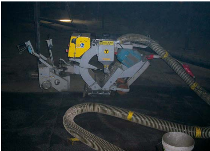
3 e 4 - Una fase operativa della pallinatrice: con l'asportazione del vecchio rivestimento le lamiere vengono messe a nudo in modo da consentire l'identificazione immediata di eventuali danni o corrosioni e l'intervento tempestivo di riparazione.
